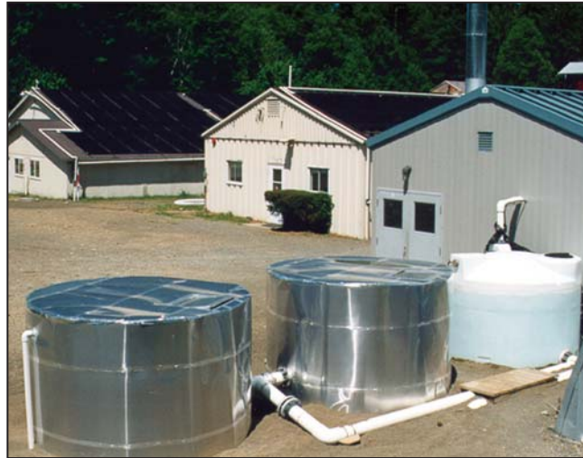
Figure 5 : Projet de chauffage solaire de l'eau dans une ferme productrice d'alevins de saumon, Canada.
