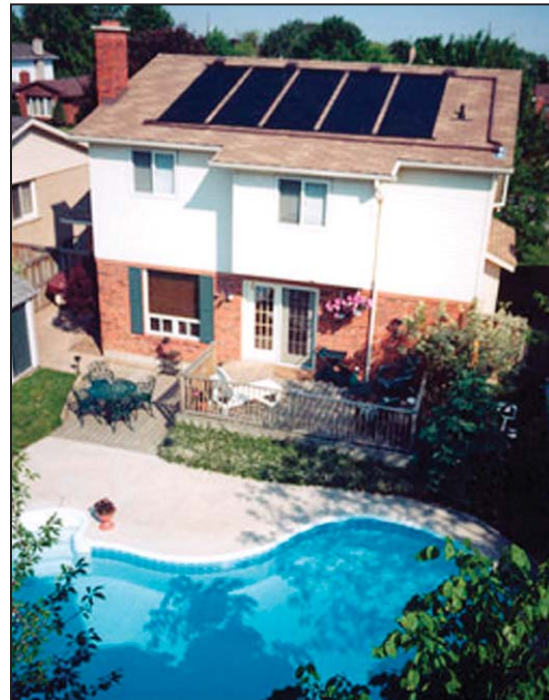
Figure 6 : Système de chauffage de piscine avec capteur solaire sans vitrage aux États-Unis.
