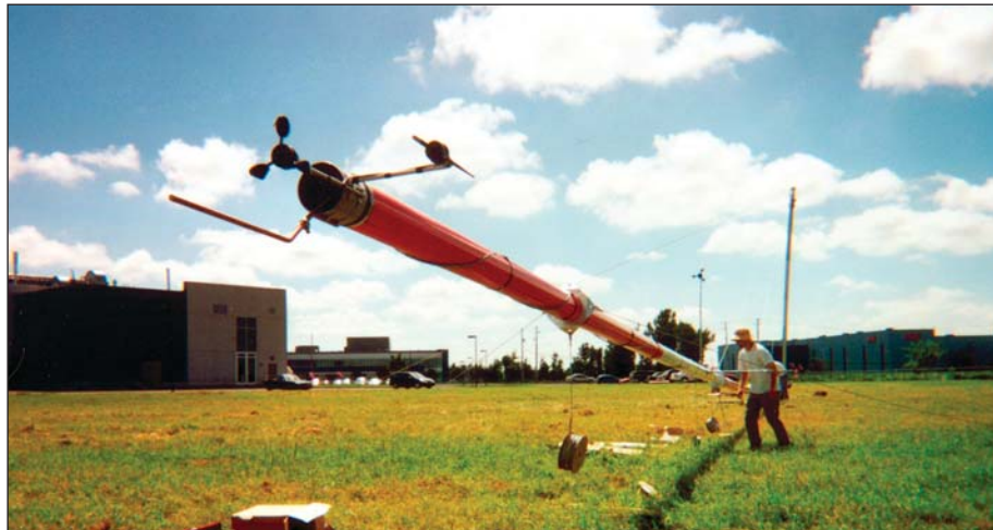
Figure 7 : Installation d'un mât météorologique de 40 m.
