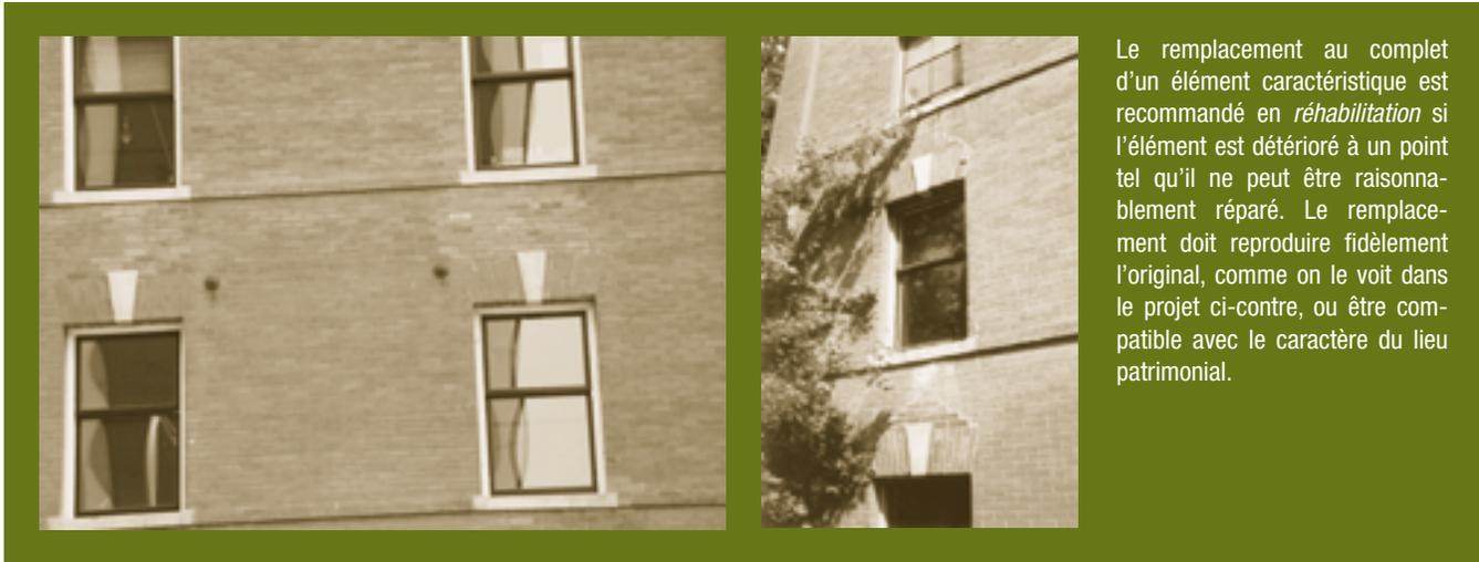
Le remplacement au complet d'un élément caractéristique est recommandé en *réhabilitation* si l'élément est détérioré à un point tel qu'il ne peut être raisonnablement réparé. Le remplacement doit reproduire fidèlement l'original, comme on le voit dans le projet ci-contre, ou être compatible avec le caractère du lieu patrimonial.
