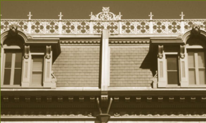
Pour la *réhabilitation*, il est recommandé de remplacer par un élément identique tout élément en métal architectural trop détérioré pour être réparé, si la forme et les détails généraux sont encore évidents. La crête en métal manquante du toit de la résidence Shaughnessy à Montréal a été remplacée et on a utilisé les preuves matérielles existantes pour reproduire l'élément.
