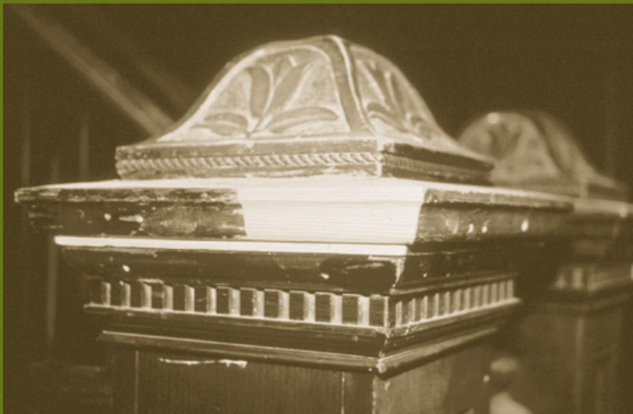
Un exemple de « remplacement limité à l'identique » illustre l'ampleur qu'il convient de donner à des travaux dans un traitement de *préservation*. Seul le coin endommagé d'un poteau de départ d'escalier a été remplacé (il sera teint pour se marier au reste). Limiter les réparations aux éléments détériorés a permis de conserver la plupart des matériaux caractéristiques.
