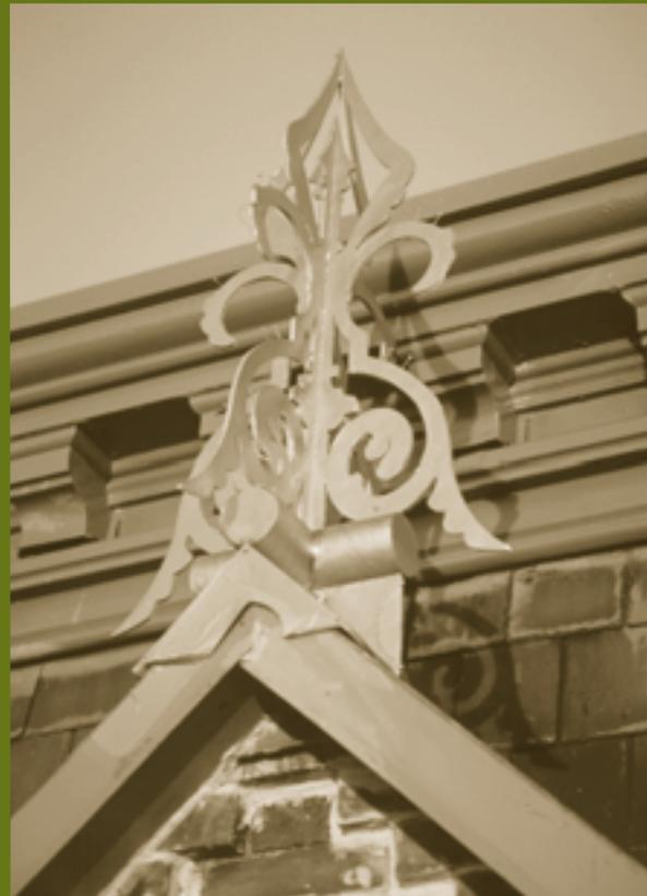
Dans certaines circonstances, les matériaux de substitution peuvent être appropriés. Dans le cadre d'un projet de *réhabilitation*, on a conçu de nouveaux faîteaux en fonction des éléments originaux subsistants. Les éléments originaux avaient été fabriqués de minces pièces de métal galvanisé soudées ensemble. Dans la nouvelle conception, on a utilisé l'aluminium plaqué comme matériau de substitution.
