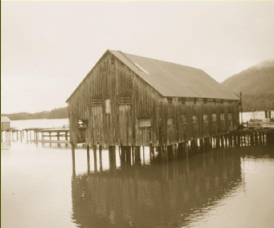
Il est important de déterminer la cause précise des dommages survenus à un élément d'un bâtiment en bois avant d'entreprendre tout traitement de *préservation*. Dans le cas de l'ancien atelier des machines de la North Pacific Cannery, l'exposition aux conditions maritimes a mené à la détérioration du recouvrement extérieur en bois.
