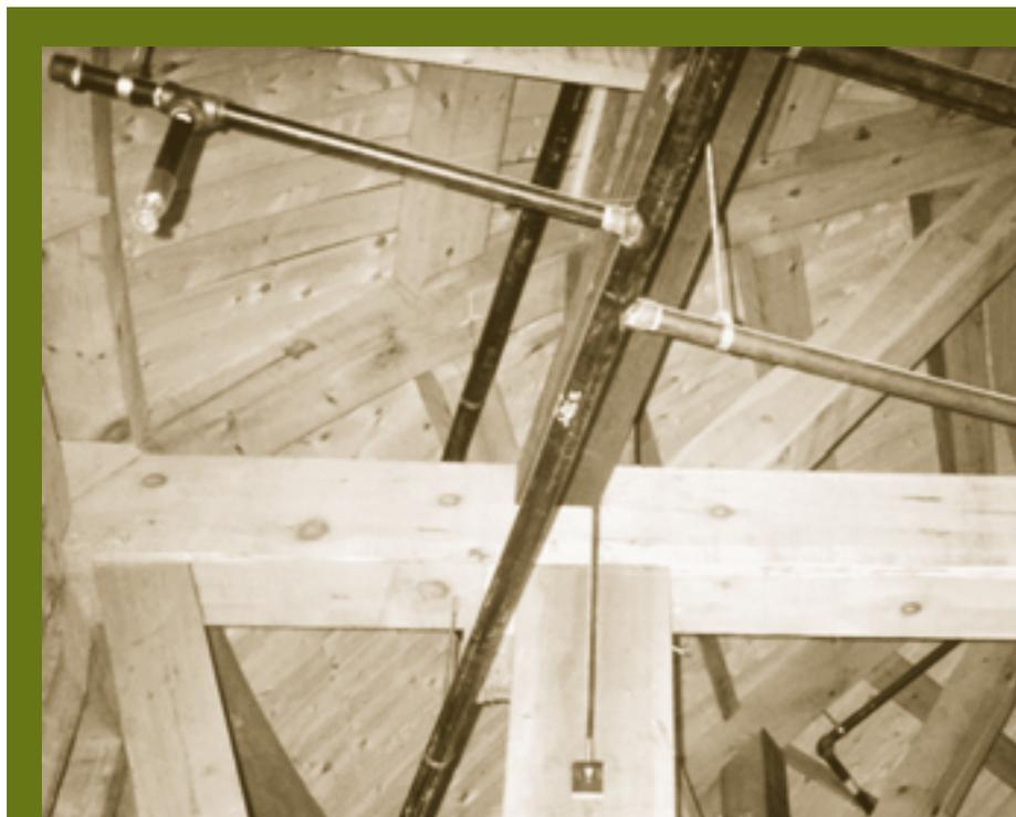
Il faut installer les nouveaux systèmes mécaniques en modifiant le moins possible le bâtiment. Dans le projet de *restauration* de la St. George's Anglican Church de Halifax après un incendie dévastateur, on a pris soin de ne pas modifier ni de masquer la charpente et les éléments intérieurs caractéristiques datant de la période de référence pour la restauration lorsqu'on a installé un nouveau système de gicleurs dans les combles.
