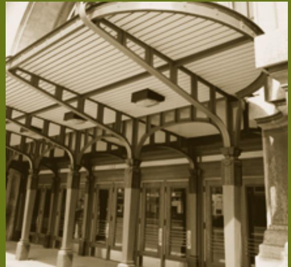
Un programme régulier de nettoyage et d'application de peinture appropriée a remarquablement préservé l'auvent en métal de l'entrée de la gare Union de Winnipeg, construite en 1911. La protection contre la corrosion doit être le premier moyen à envisager pour préserver les métaux architecturaux.
