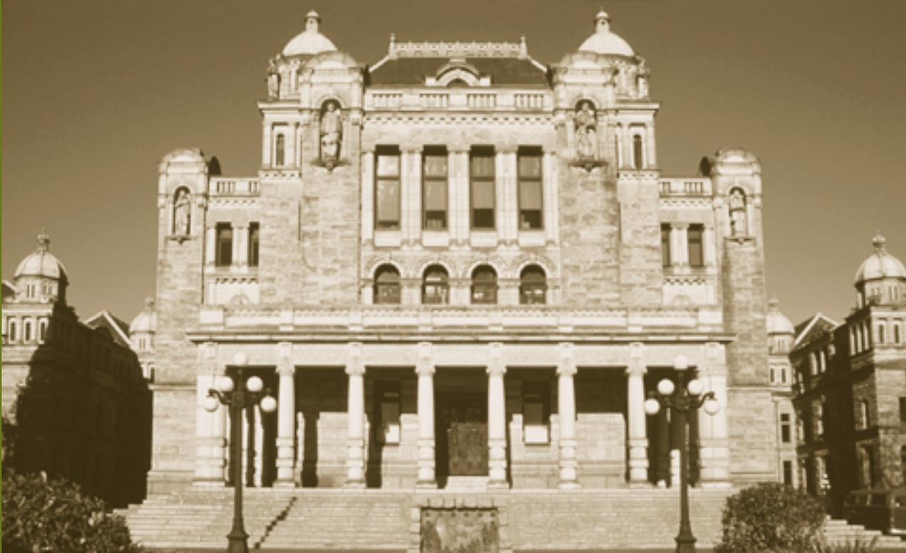
La *préservation* de l'extérieur de l'Édifice de l'Assemblée législative de la Colombie-Britannique (dont on voit ici la façade arrière), y compris les murs de maçonnerie, les marches, les colonnes, les pilastres, les pourtours des fenêtres, les détails décoratifs et les corniches, a commencé par une documentation des matériaux, de la forme, du jointoiment, des marques d'outils, de l'appareillage, des enduits, de la couleur et de l'état des éléments.
