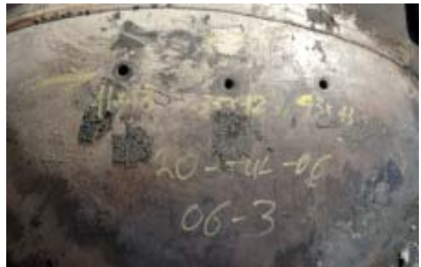
Figure 10 – Orifices d'évacuation dans la partie inférieure de la citerne de l'Essai 06-3
