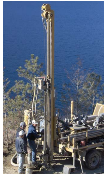
Une équipe de techniciens qui s'apprêtent à forer des trous pour un système d'énergie géothermique.
