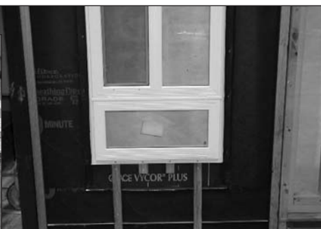
Monter la fenêtre à bride sur des fourrures (ci-dessus) ou insérer des cales derrière la bride (à gauche) permet d'obtenir les ouvertures nécessaires pour un bon drainage.
