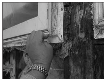
Effets des infiltrations d'eau autour des fenêtres
