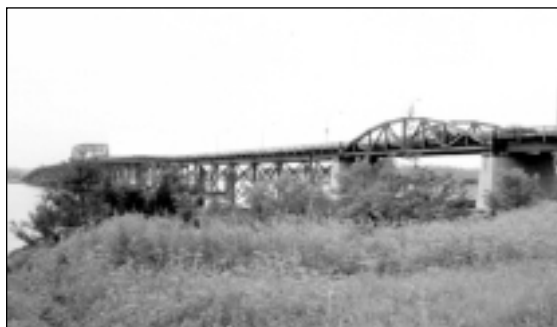
L'ancien pont Perley
