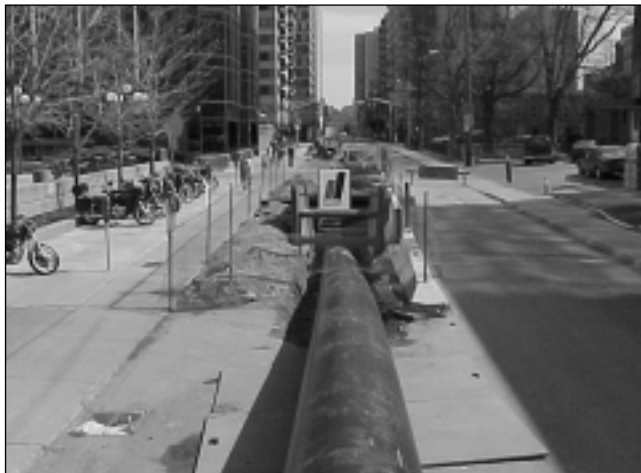
Figure 1. Réhabilitation par tubage d'une conduite, rue Gloucester, Ottawa
