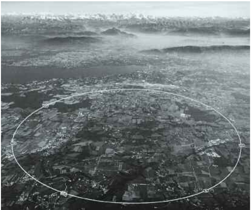
Vue aérienne du site du CERN, près de Genève (Suisse). Le grand cercle blanc représente l'emplacement du tunnel du LHC, à environ 50 m sous la surface.
