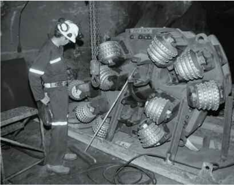
Un tunnelier utilisé pour excaver le nouveau laboratoire SNOLab dans la mine Creighton.
