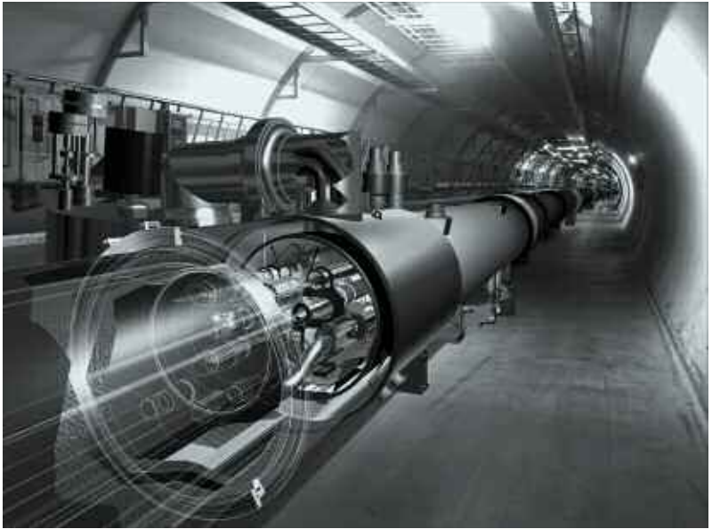
Maquette du tunnel du LHC du CERN illustrant les deux canalisations contenant les faisceaux de protons de 7 TeV qui circuleront dans l'anneau de 27 km.
