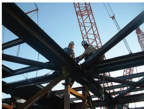
Monteurs de charpentes d'acier à l'oeuvre
