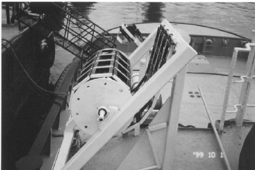
Installation permanente du dispositif de récupération (engin de sauvetage Jason) à bord d'un remorqueur servant de bateau-pilote à Québec
