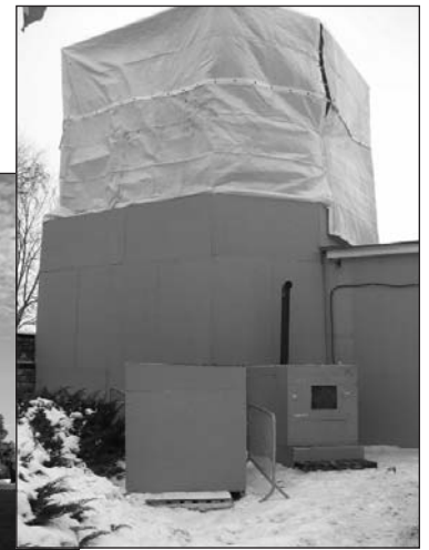
Structure porte-drapeau sur le mur Vaux de la colline du Parlement (gauche); même structure équipée d'une enceinte chauffée après application du mortier (droite).
