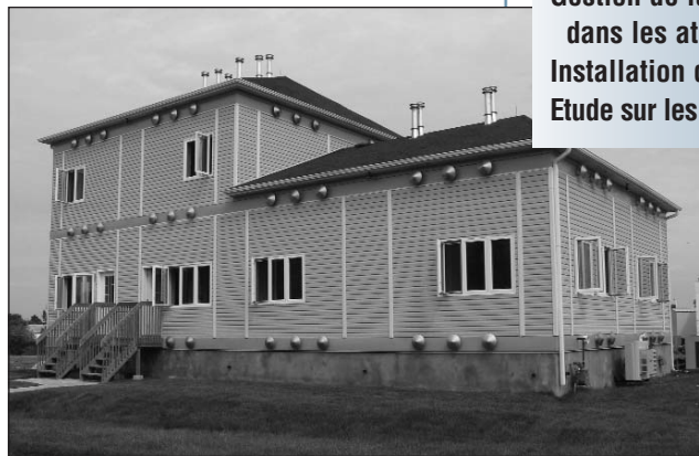
Nouvelle installation de recherche sur l'air intérieur dans le cadre de l'initiative sur la qualité de l'air intérieur de l'IRC-CNRC
