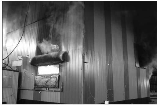
Installation de recherche sur le comportement au feu des maisons.
