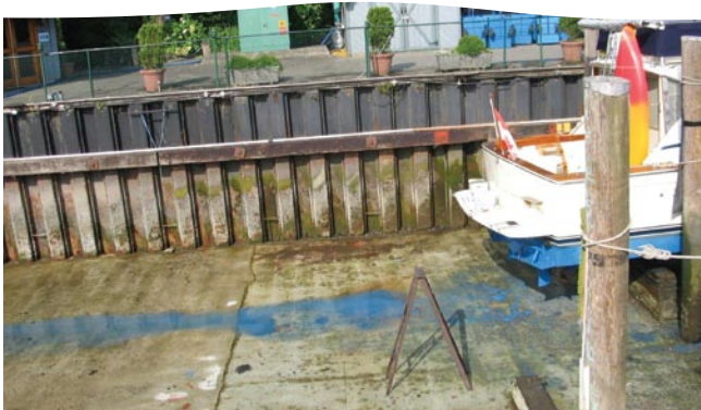
Bateau lavé à la pression sur un dispositif doté d'un système de confinement qui recueille les déchets de peinture antisalissure.
