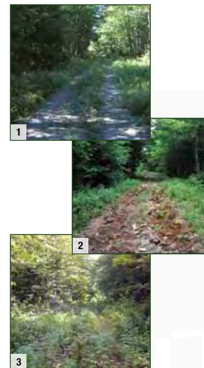
1-3 Serie cronológica de la restauración de la Carretera Laverly en la que se muestra: 1) un tramo de la carretera antes de la restauración en 1999, 2) el lecho escarificado de la carretera y los árboles y arbustos nativos plantados en 2000, y 3) el tramo restaurado en 2007, Parque Nacional de Canadá Fundy (Nuevo Brunswick) Fotografía: J. Watts 4 Un ostrero negro ( Haematopus bachmani ) en la Reserva del Parque Nacional de Canadá Pacific Rim (Colombia Británica) Fotografía: Agencia de Parques de Canadá Arriba Pradera de hierbas altas en la Reserva Natural Provincial de la Pradera Ojibway (Ontario) Fotografía: Ministerio de Recursos Naturales de Ontario
