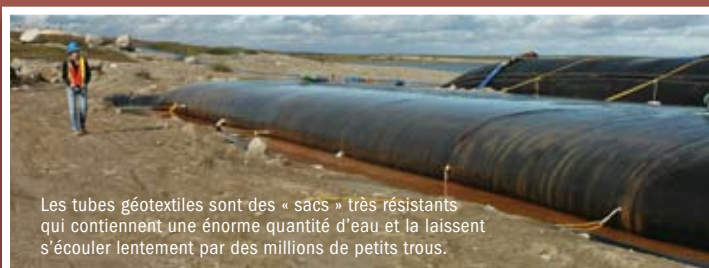
L'eau qui se trouve à l'intérieur du sac sort par les trous sous l'effet de la pression, et les contaminants restent à l'intérieur.
