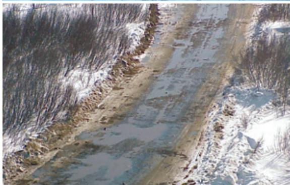
FIGURE 31. (Top) Les routes d'hiver ne peuvent pas être empruntées par des véhicules à roues lourds tant qu'elles ne sont pas recouvertes d'au moins 10 cm de neige compactée. L'herbe qu'on peut voir sur cette route indique que l'épaisseur de la neige est inférieure à 10 cm.
