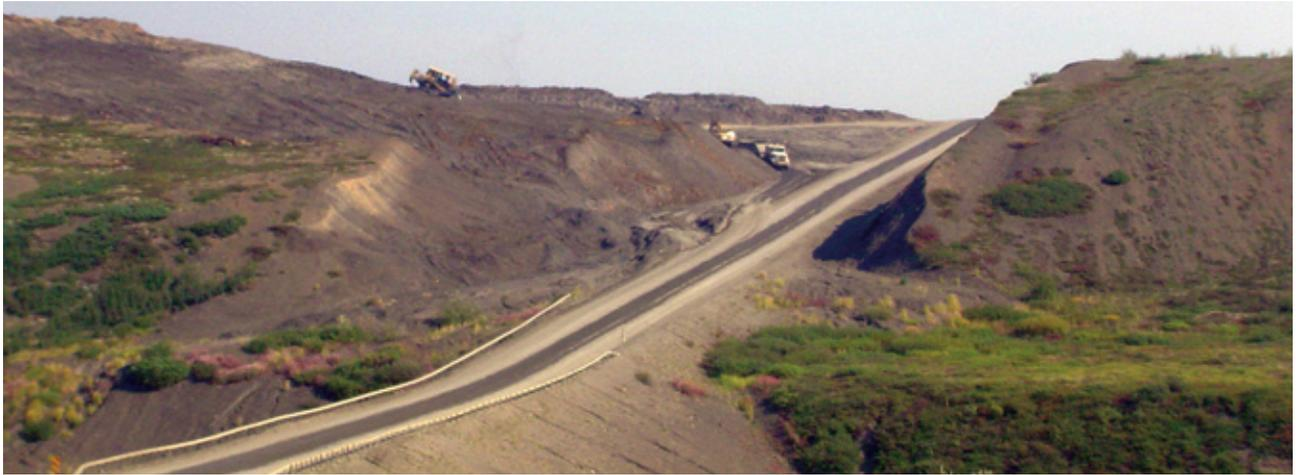
FIGURE 16. On a réduit la pente de cette route à l'aide des déblais provenant de l'excavation adjacente.
