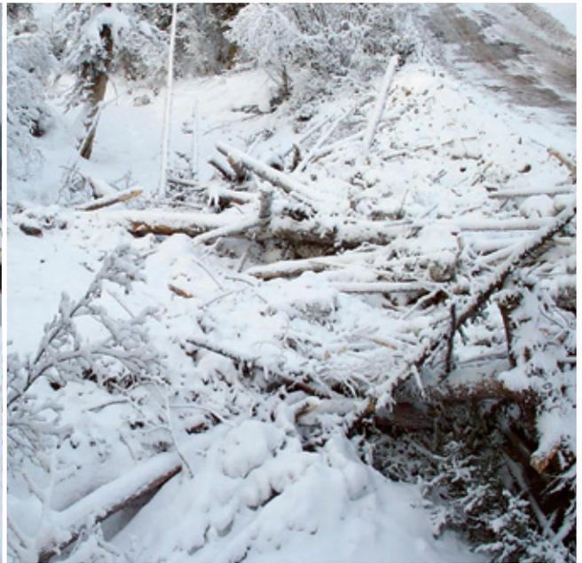
FIGURE 34. Remblai de neige piètrement aménagé qui consiste en des broussailles et de la neige mélangées.
