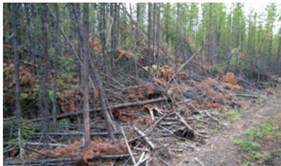
FIGURE 15. Enlèvement inadéquat des broussailles dans la végétation forestière. On doit couper les arbres penchés et disposer les broussailles en andains.
