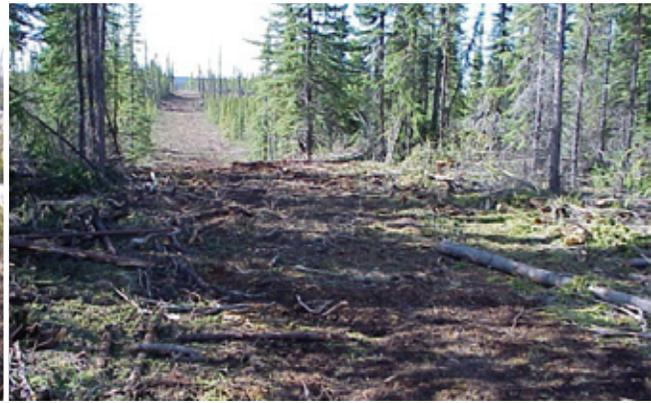
FIGURE 10. Ne défricher que la largeur minimale nécessaire pour la route.
