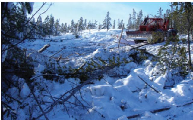
FIGURE 11. Les broussailles peuvent être renversées à l'aide d'un boteur.
