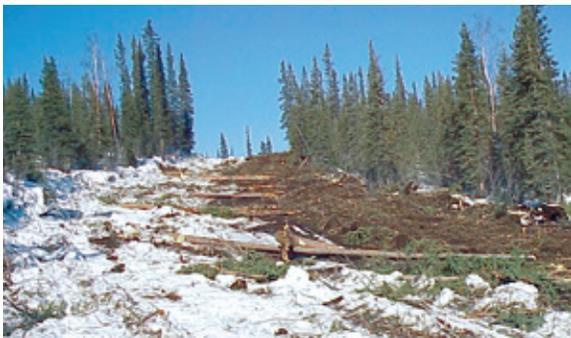
FIGURE 14. On peut se servir des broussailles comme collecteur de sédiments sur les talus abrupts.
