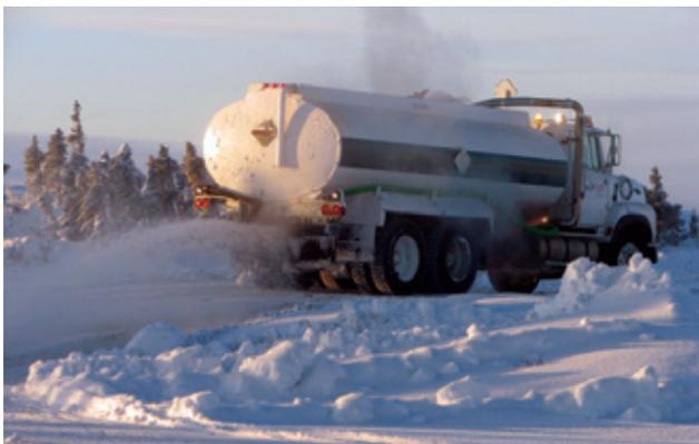
FIGURE 30. On peut réaliser la surface de la route en glace, à l'aide d'un camion-citerne doté d'un pulvérisateur.
