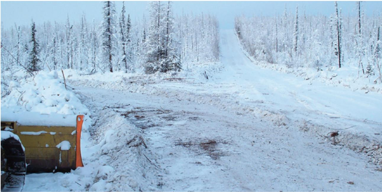
FIGURE 8. En vérifiant le tracé avant la construction, on peut éviter les faux départs inutiles comme celui-ci.
