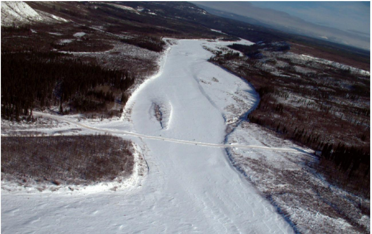
FIGURE 35. Pont de glace construit sur un grand cours d'eau.
