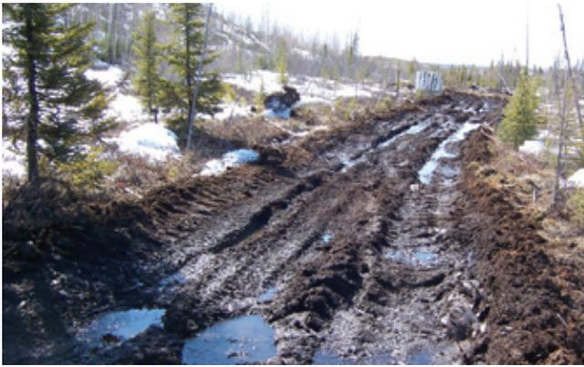
FIGURE 9. L'établissement d'un calendrier adéquat pour la construction de la route permet d'éviter l'orniérage et l'érosion.
