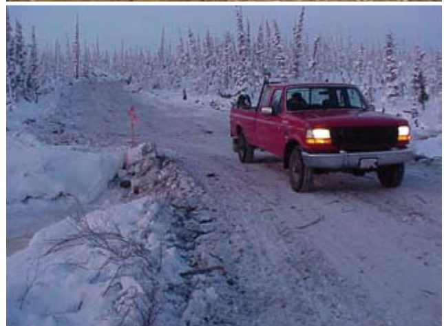
FIGURE 11. La tranchée de drainage sert à diriger l'eau vers un bassin de décantation à l'intérieur de la fosse.
