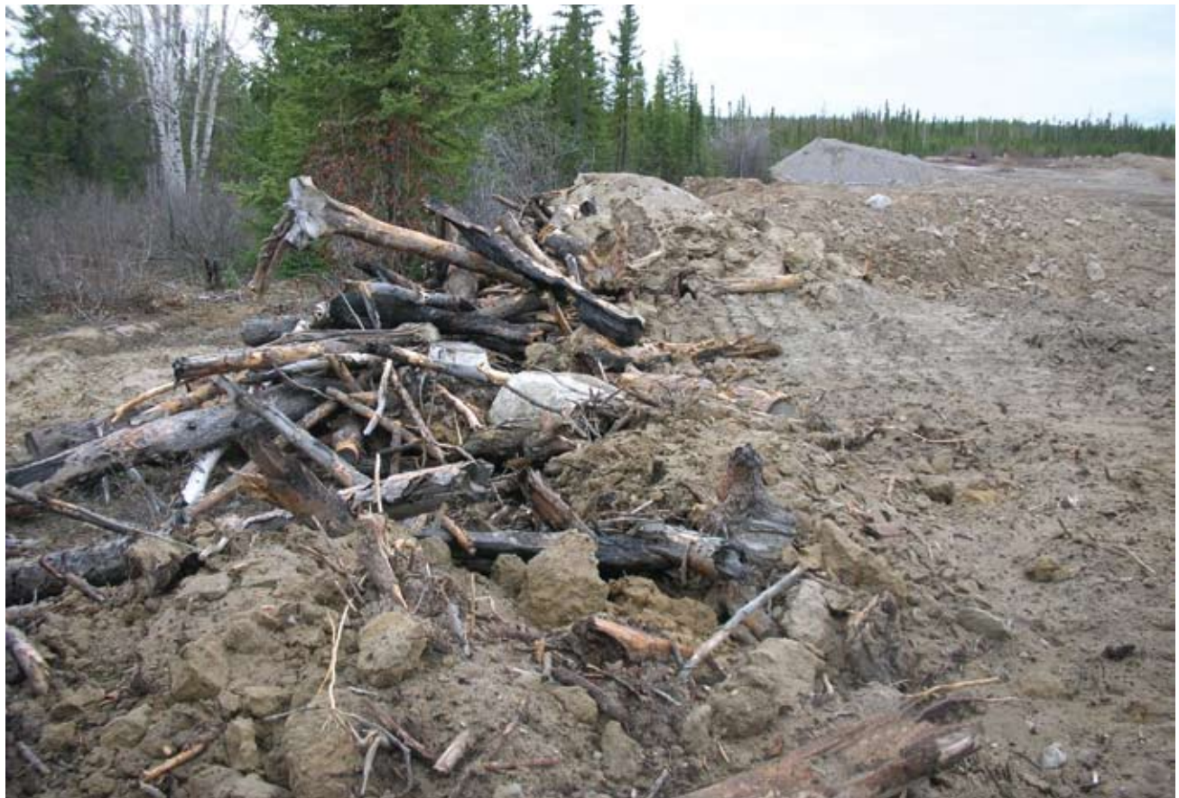
FIGURE 20. Il est conseillé de ne pas mélanger les morts-terrains et les débris ligneux, et de les empiler à au moins 5 m des arbres sur pied.
