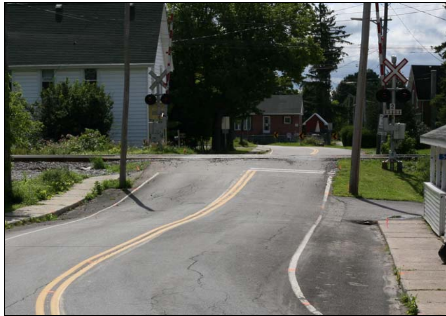
Photo 2. Passage à niveau du chemin Quabbin vers le sud
