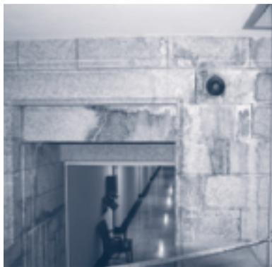
Édifice du Centre — L'infiltration d'eau sur l'acier de la structure a occasionné des taches de rouille permanentes sur la finition intérieure en pierre dans certaines sections, notamment les salles et les lieux de cérémonie.
