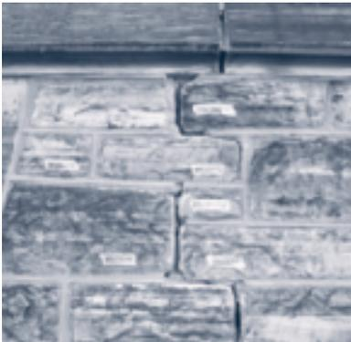
Édifice de l'Ouest — L'infiltration d'eau dans les structures principales cause l'érosion du mortier.
