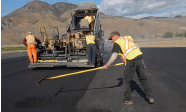
Des travailleurs locaux travaillent au prolongement de la piste de l'aéroport international de Kelowna.
