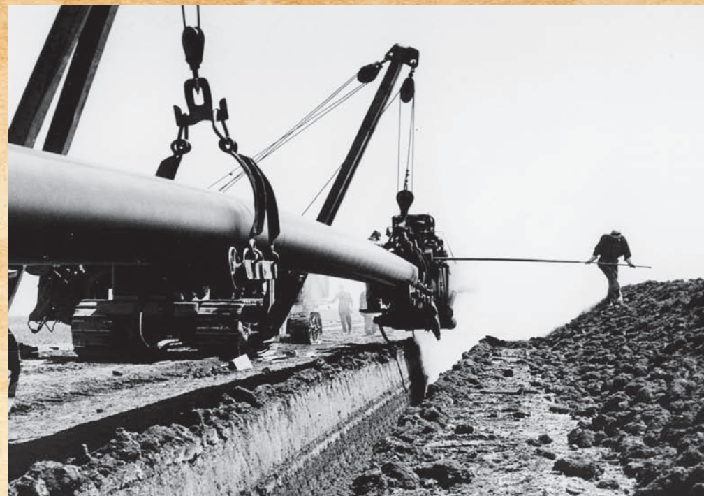
Wrapping and laying interprovincial oil pipeline outside Regina, Saskatchewan July 1954. Source: Library and Archives Canada/Credit: Julian Biggs, National Film Board/Canada. Dept. of External Affairs collection/PA-122742 * Mise en forme et en place d'un oléoduc interprovincial près de Regina, en Saskatchewan, en juillet 1954. Source : Bibliothèque et Archives Canada/Crédit : Julian Biggs, Office national du film/Collection du ministère des Affaires étrangères du Canada/PA-122742
