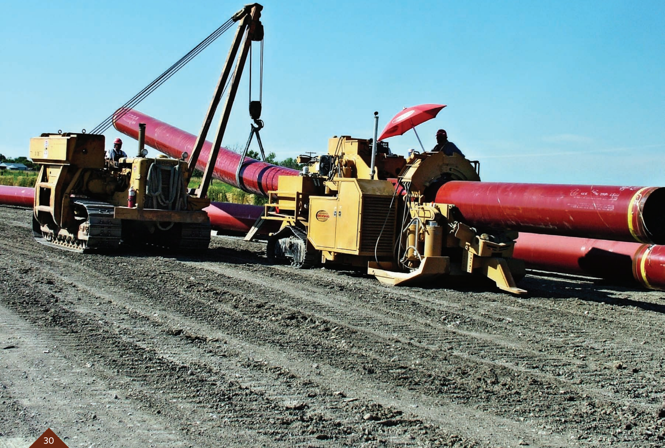
Pipeline Bending on Enbridge Clipper pipeline, near Moosomin, Saskatchewan, August 2009. (NEB Photo) ✦ Courbement du pipeline Clipper d'Enbridge près de Moosomin, en Saskatchewan, en août 2009. (photo de l'ONÉ)
