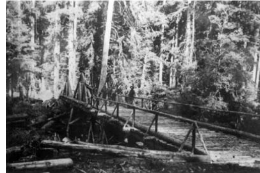
Pont sur chevalets près de la pointe Pachina, sur le sentier des rescapés de la Côte-Ouest. Collection de la Division des services maritimes du ministère des Transports, Victoria
