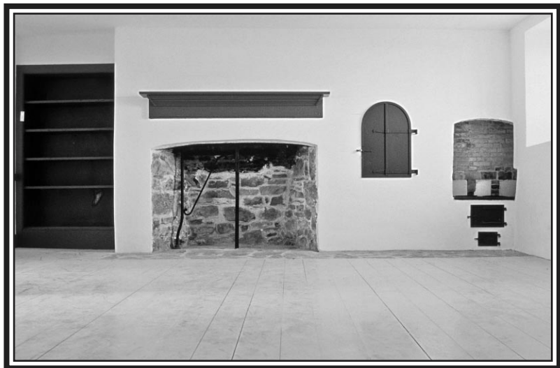
Foyer ouvert et four situés au sous-sol
