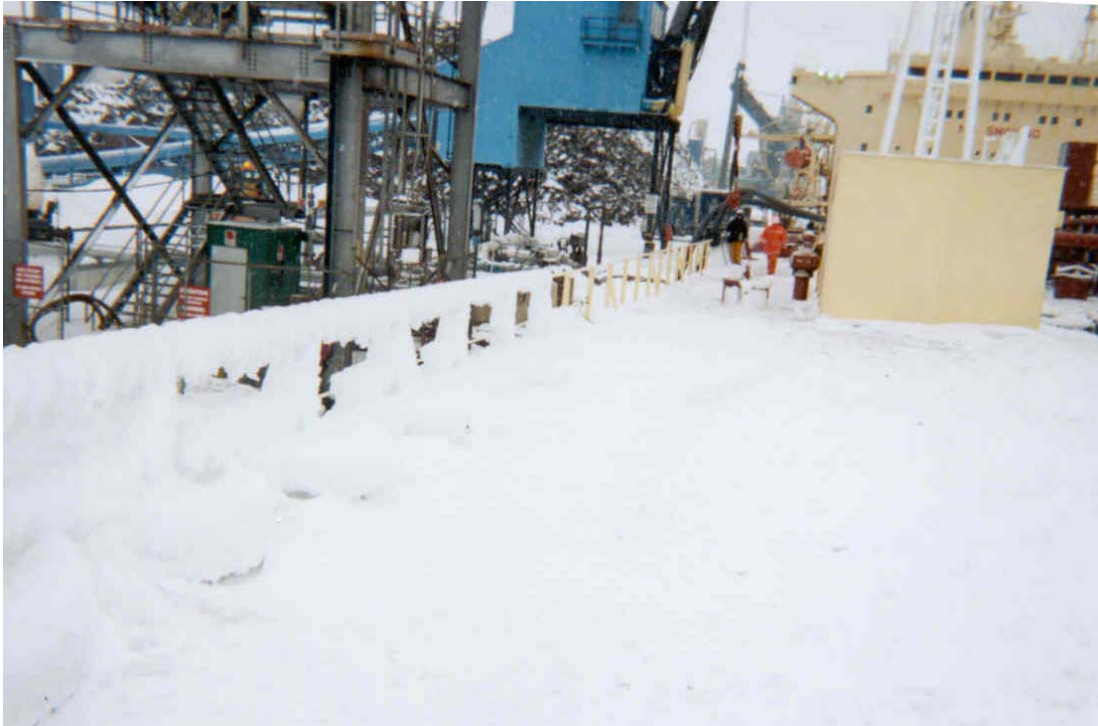
Figures 5.3C – Partie centrale du pont glacée
