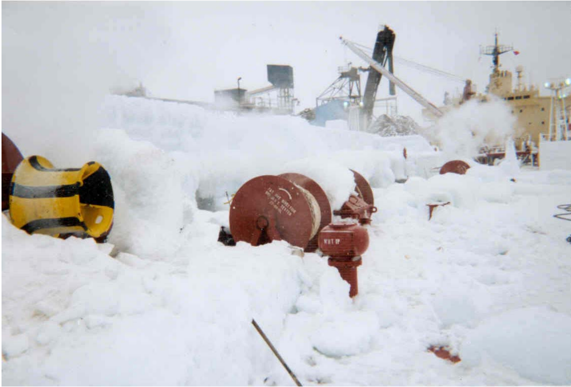
Figures 5.3E – Structure avant entièrement sous la glace
