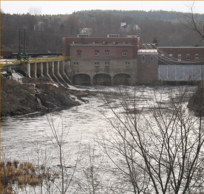
Figure 1 : Centrale Énergie NB sur la rivière Sainte-Croix, à Milltown
