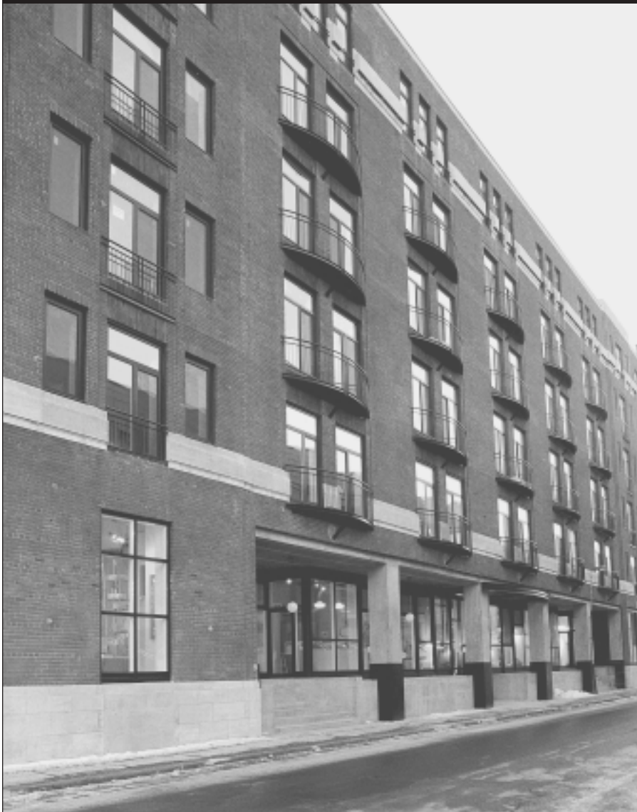
Figure 2.48 : Vue de la façade des Sœurs-Grises à partir de la rue de la Commune
