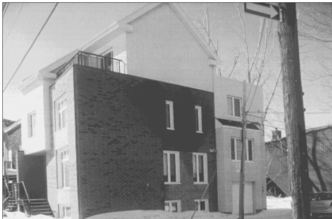
2.13a : Entrées des deux appartements se trouvant dans le corps de la maison (photo du haut)
