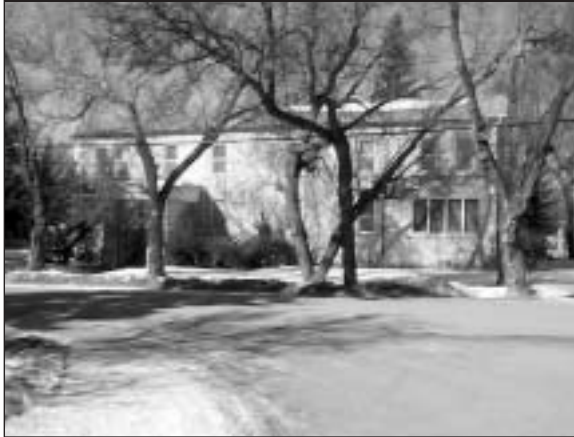
Convent transformé en logements locatifs, Russell
