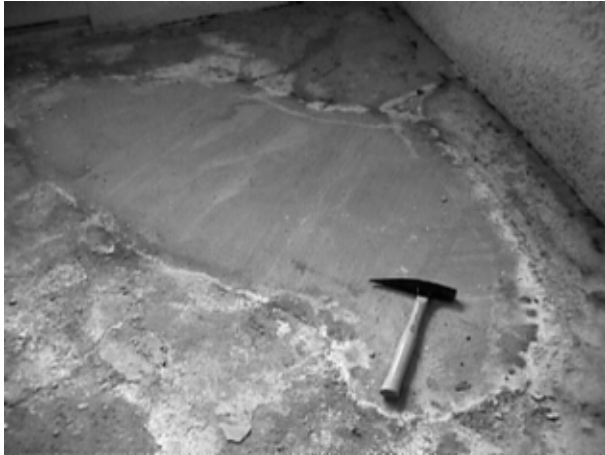
Figure 11. Béton égalisé
