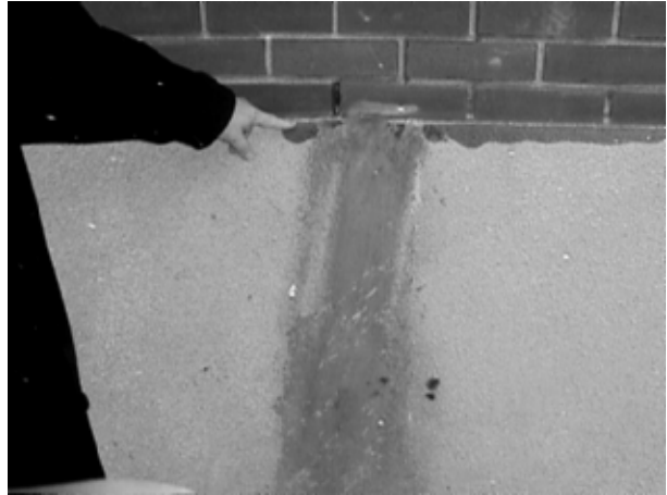
Figure 12. Fissure colmatée
