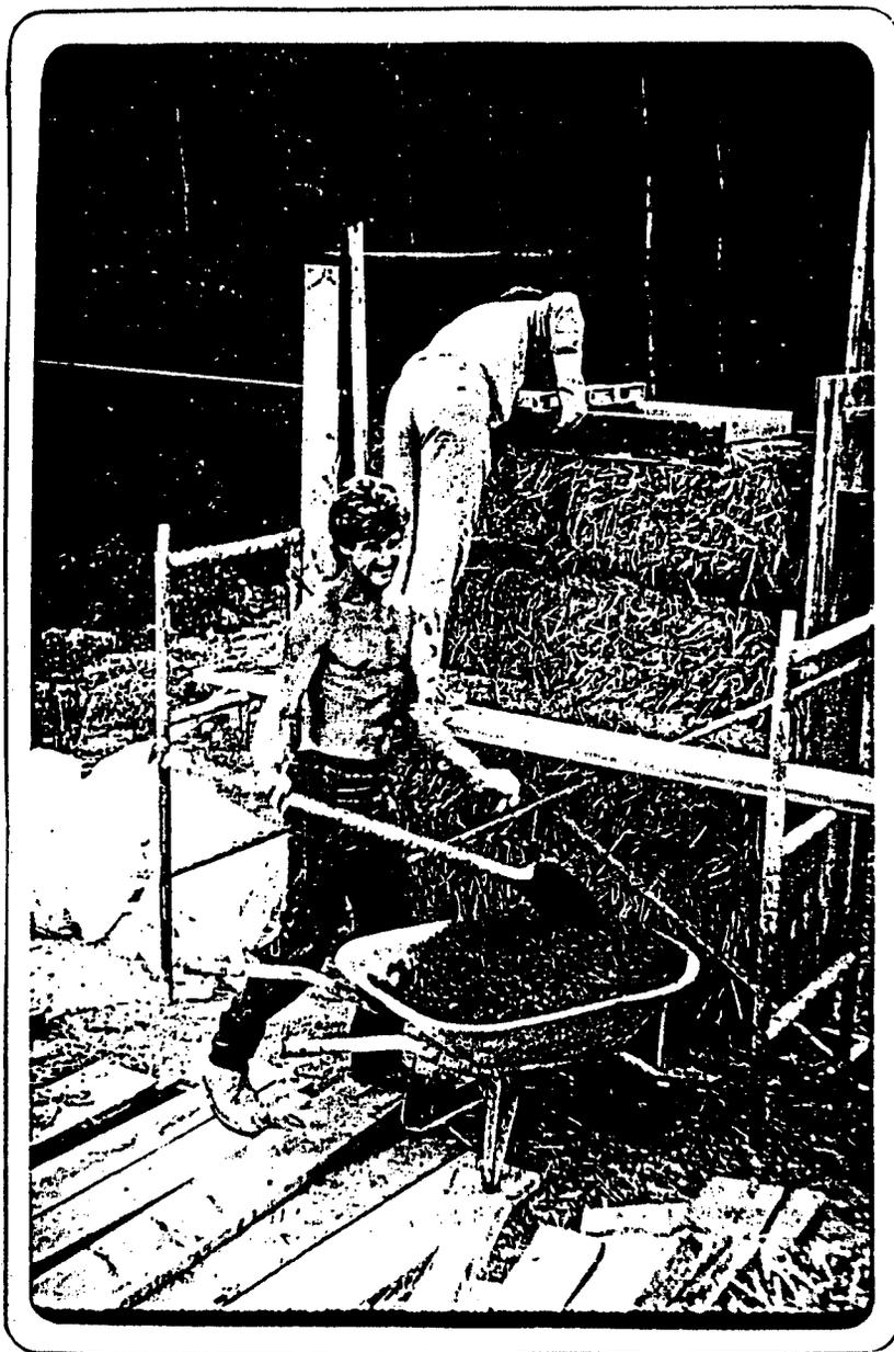
C.8 Remplissage du coffrage de mortier pour former le joint horizontal.
