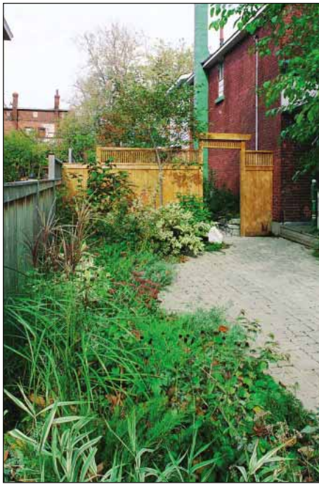
Figure 7 Pour réduire le ruissellement et embellir leur propriété, les propriétaires ont réduit les dimensions de leur voie d'accès de 60 % en y plaçant des plantations. Ils ont également remplacé l'asphalte du reste de la voie d'accès par des pavés en béton préfabriqués.
