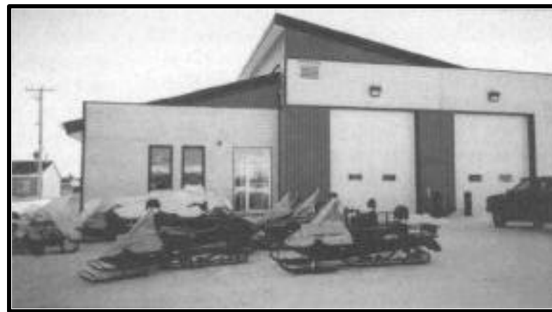
Vue extérieure de la caserne d'incendie à Whapmagoostui.
