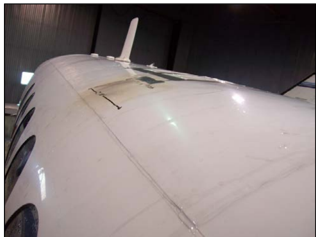
Photo 1. Dommages vus de l'extérieur
