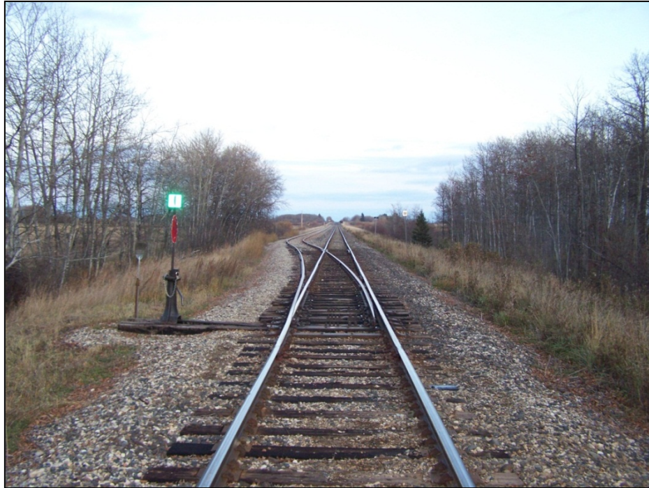
Photo 1. Aiguillage ouest de la voie d'évitement à Meharry (vue en direction est)
