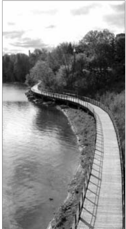
La passerelle longeant la rivière des Outaouais au sud du parc Jacques-Cartier
