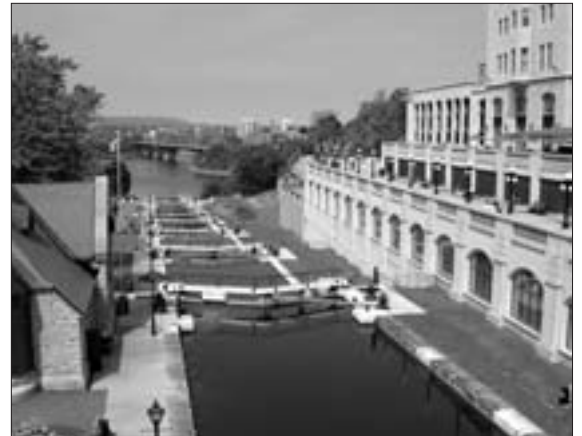
Les écluses du canal Rideau à proximité du Château Laurier
