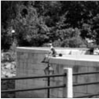
Les écluses du canal Rideau
