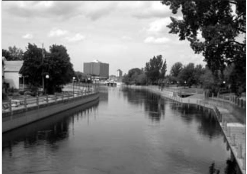
Le ruisseau de la Brasserie, vue vers le nord
