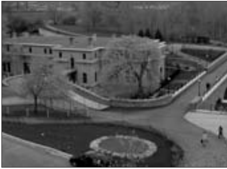
Station de pompage de la rue Fleet
