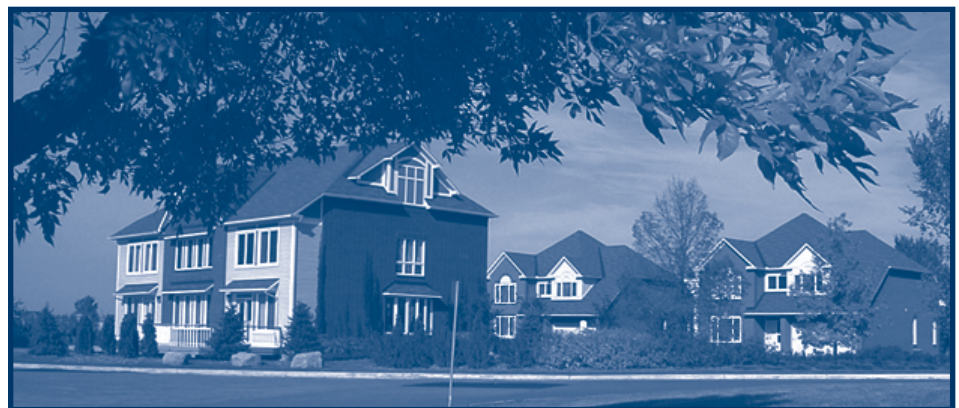
L'installation de recherche et de démonstration du CCTR aménagée en 1998 se compose de deux maisons R-2000 identiques et dotées de nombreux instruments. On y simule l'occupation humaine pour évaluer le rendement global des nouvelles technologies grâce à des tests côte à côte. Photo : Ken Ruest, Société canadienne d'hypothèques et de logement.
