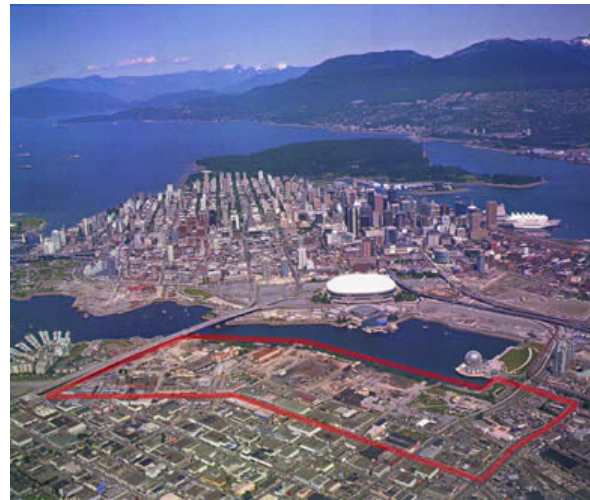
Southeast False Creek : le site d'un grand projet de revitalisation
