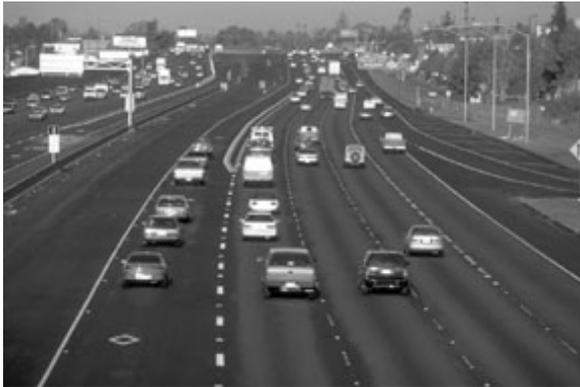
*Voie à péage pour véhicules à plusieurs occupants (marques en forme de carreau, à gauche) sur la I-15 à San Diego
