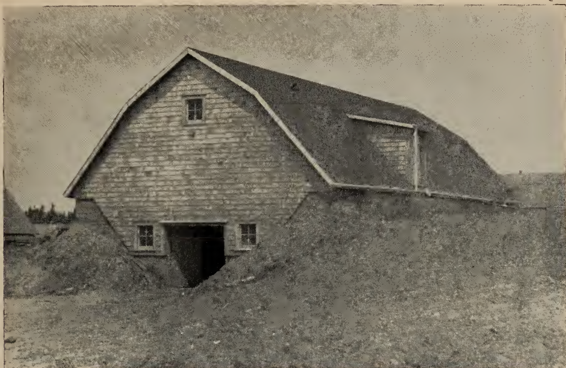
Fig. 2.—Entrepôt aménagé à même un talus. La partie émergente est de bois et la partie inférieure en béton.
