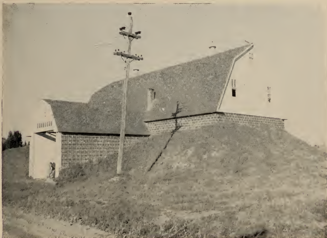
Fig. 3.—Entrepôt aménagé à même un talus. Construction en blocs de ciment.
