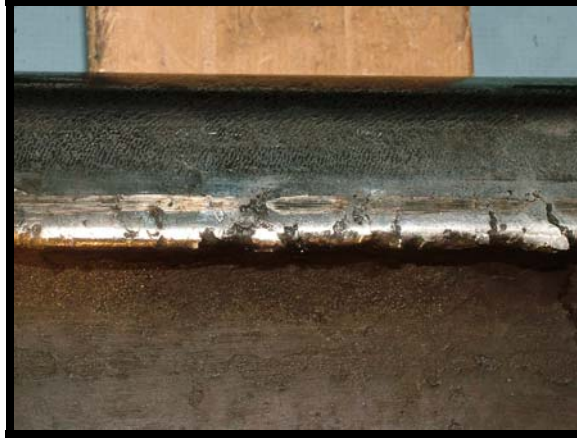
Photo 8. Face intérieure du rail montrant des signes d'éraflures et de déchirures
