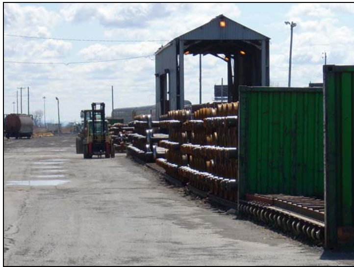
Photo 4. Installation de réparation rapide sur la voie W01
