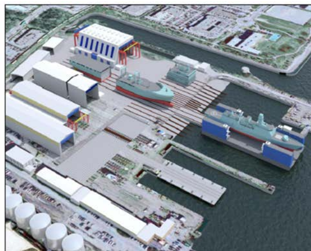
Installations après la modernisation
