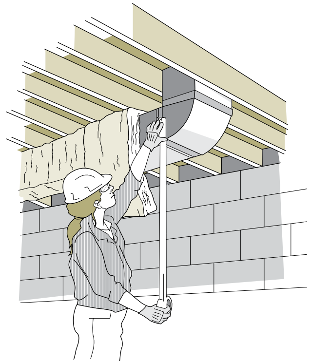
Figure 9-1 Étanchéisation d'un conduit d'air à l'aide d'un ruban adhésif
