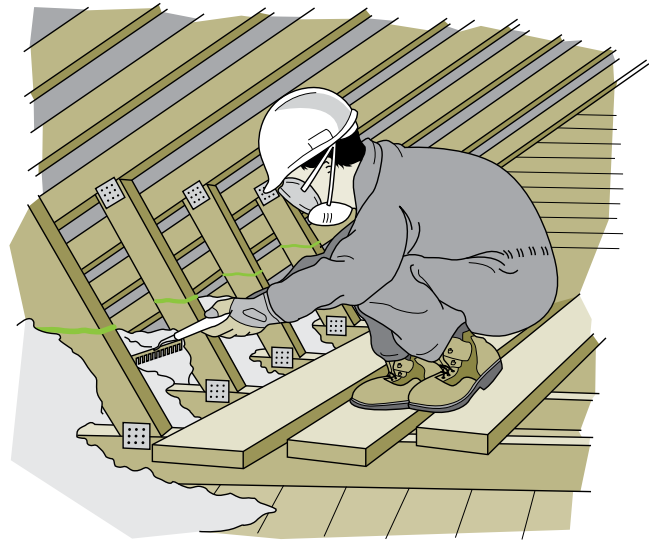
Figure 5-14 Pose de l'isolant en vrac
