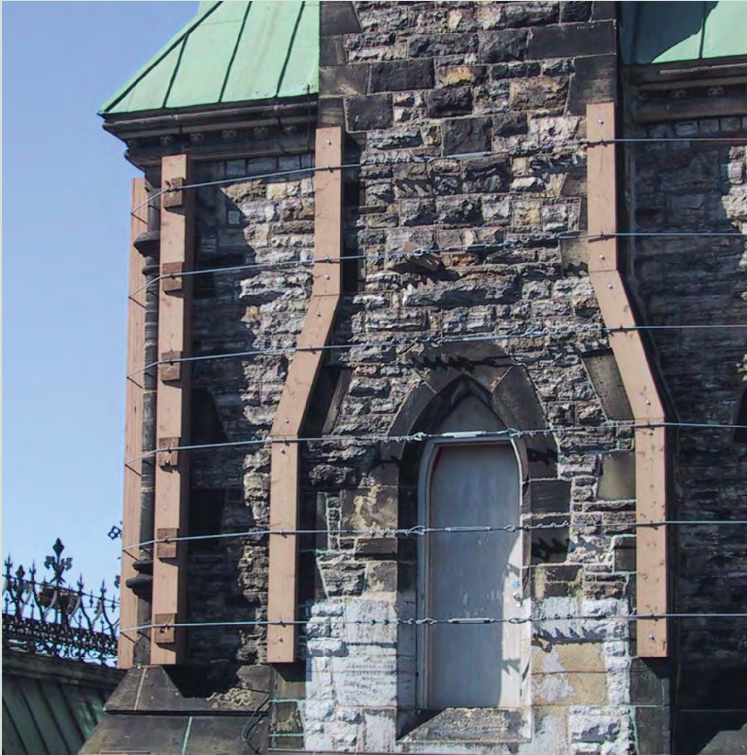
Stabilisation temporaire d'une tour de l'édifice de l'Est
