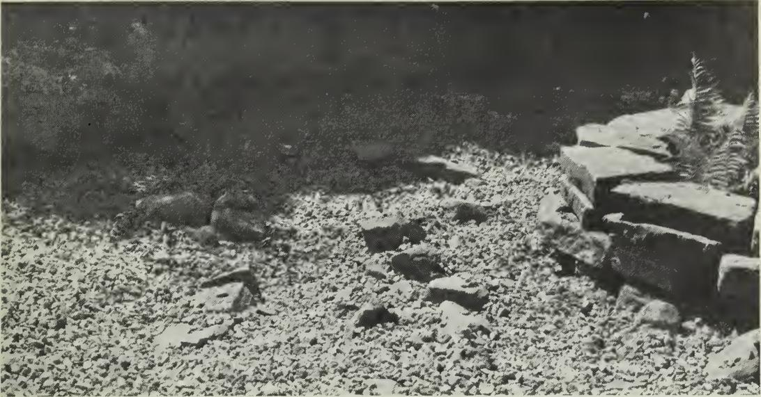
FIG. 22 Une couche de gravier recouvre la pierre concassée.
