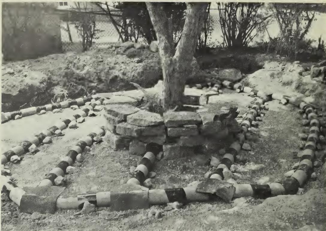
FIG. 20 Système de drainage complet avec joints recouverts.
