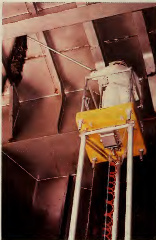
Nettoyage des corniches et des barrots d'un vraquier dans le but d'éliminer les résidus de cargaison et les éventuels foyers d'invasion d'insectes.
