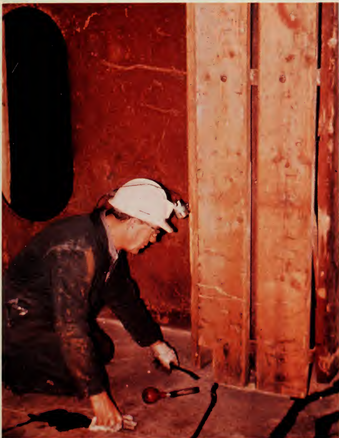
Examen de la base d'une gaine de tuyau, où le grain peut s'accumuler et des invasions d'insectes se produire.
