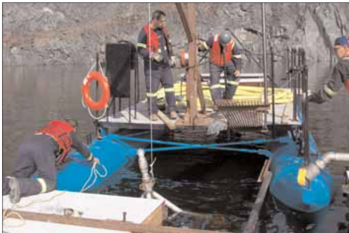
Installation du diffuseur dans le puits de la zone 2.
