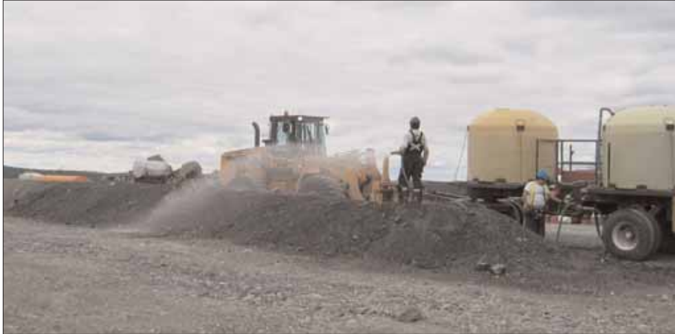
Arrosage d'un andain dans le secteur de dépôt des huiles usées pour en accroître l'humidité.
