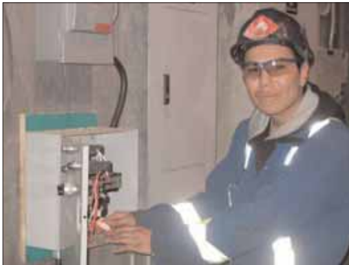
Jeremy Antoine, apprenti électricien.
