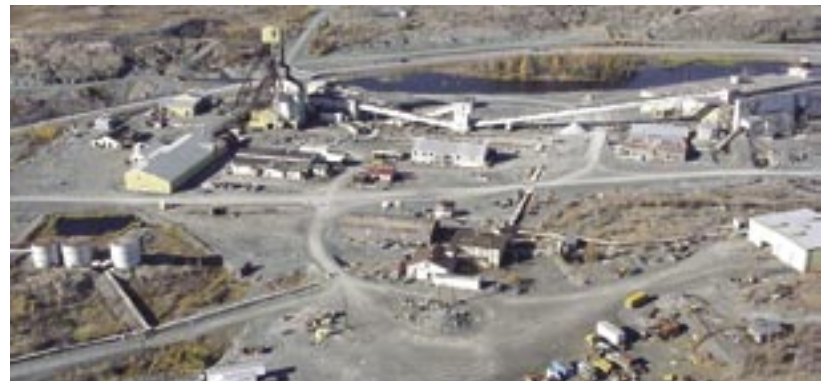
Vue des bâtiments principaux au site de la mine Giant, à Yellowknife, T.N.-O.
