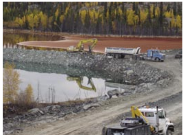
Travail sur le dyke entre le bassin de décantation et la lagune tertiaire à la mine Giant.
