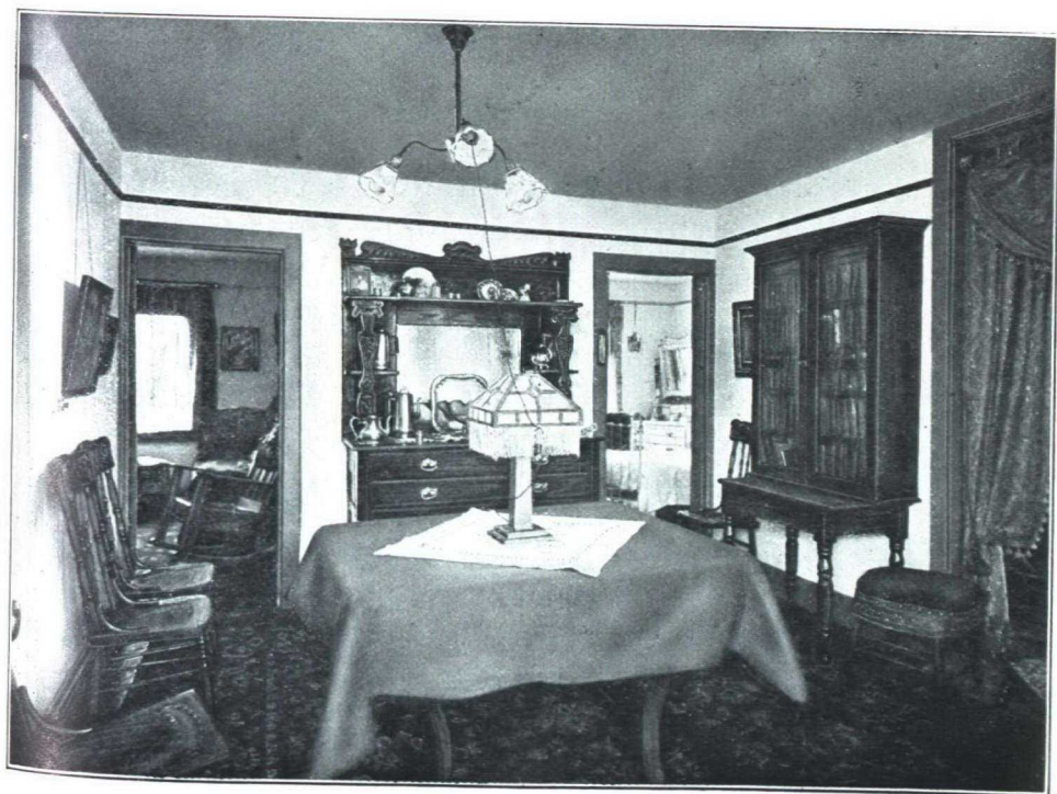
Salle principale, grand logement de cottage, Spruce Court.
