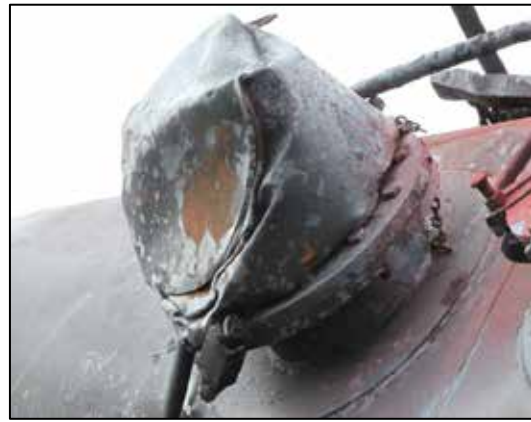
Photo 22. Enceinte à charnières installée sur les raccords supérieurs de wagon-citerne
